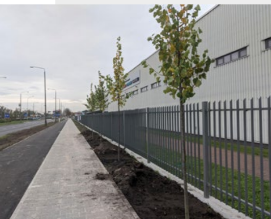
Przebudowa przestrzeni dla pieszych i rowerzystów, instalacja oświetlenia i posadzenie drzew
