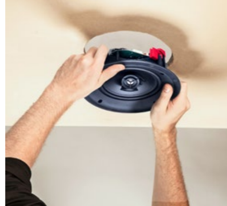
Mocowanie głośnika Martin Logan IC6-HT.
